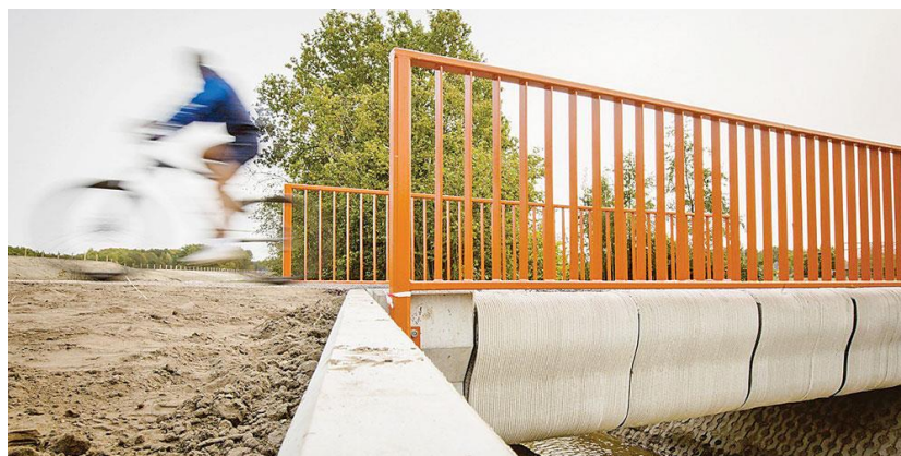
Figura 88 - Impressão em concreto reforçado de ponte para ciclistas pela Universidade Técnica de Eindhoven (TUE, 2016)
