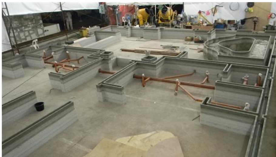
Figura 117 - Canteiro de uma impressora 3D de concreto (RUDENKO, 2015)
