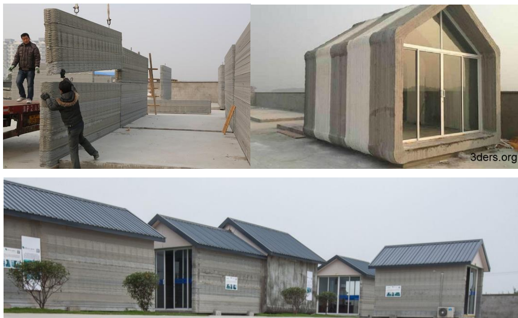
Figura 87 - Paredes robustas impressas pela empresa chinesa Winsun em ambiente de fabrica e montada no local (WINSUN, 2015)
