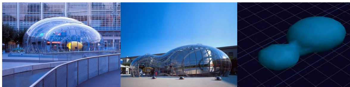
Figura 40 - Pavilhão do automóvel BMW (FRANKEN, 1999)
