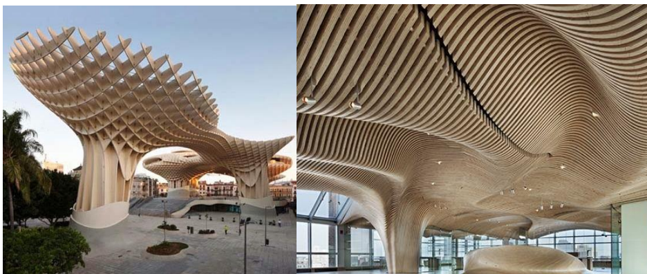
Figura 41 - Estratégia de fabricação por cortes sequenciais a) Metropol Parasol Sevilha, Espanha, (MAYER-HERMANN, 2011) B) Interior por Mark Goulthorpe (GRASSL, 2011)
