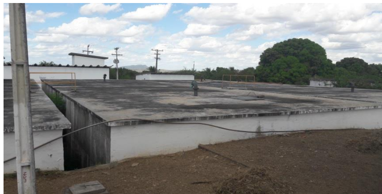
RESERVATÓRIOS ETA 03 – DELMIRO GOUVEIA – 1250 m 3 cada
