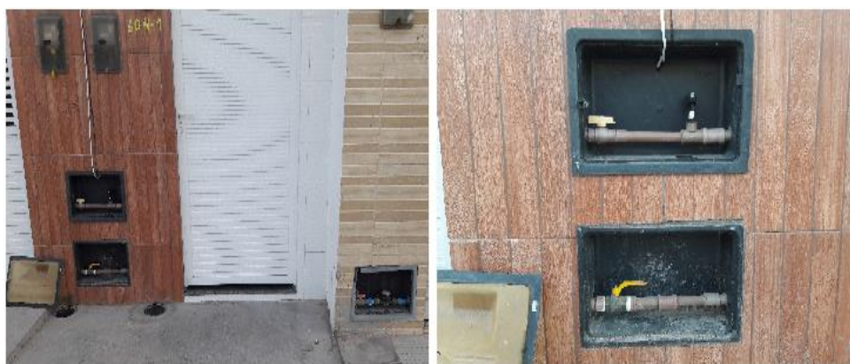
Figura 11 - Ramais sem hidrometração.
