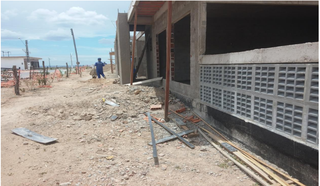
Figura 5: Funcionário fazendo a limpeza no canteiro
