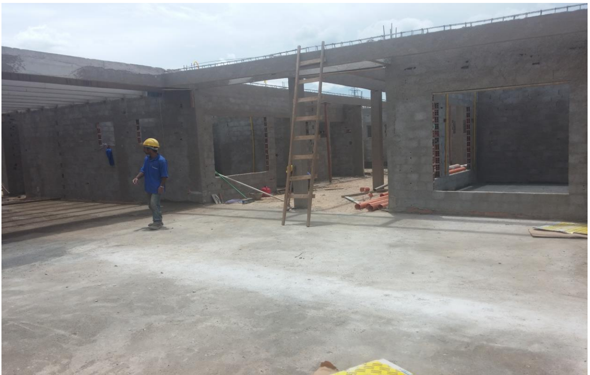
Figura 6: Funcionário organizando a limpeza dentro da obra após término de turno
