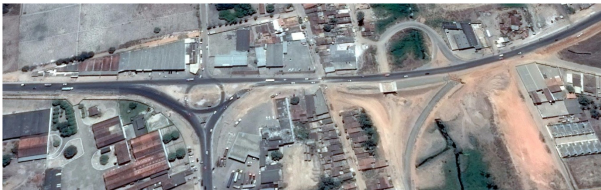
Figura 30 – Início das obras de duplicação da Rodovia AL-110.
