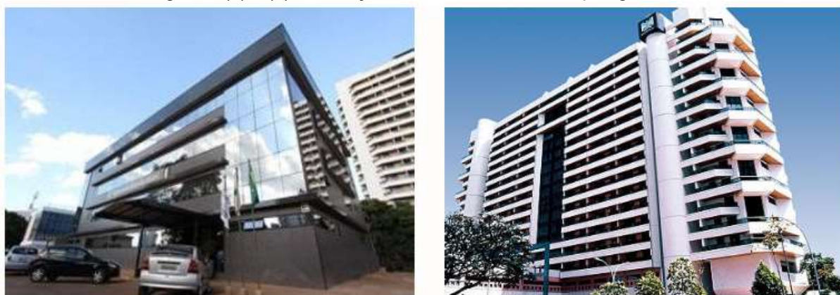
Figura 4 (a) e (b). Edificações hoteleiras conforme tipologia edilícia
