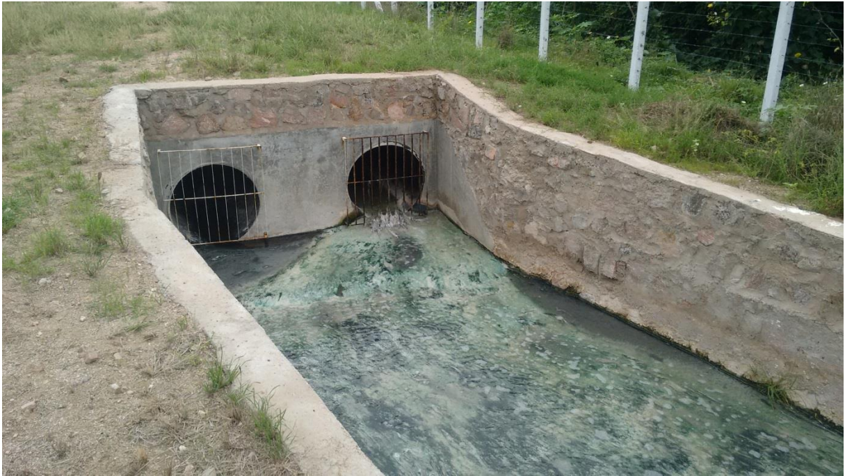
Figura 9 - Emissário, ETE 01 - Centro.
