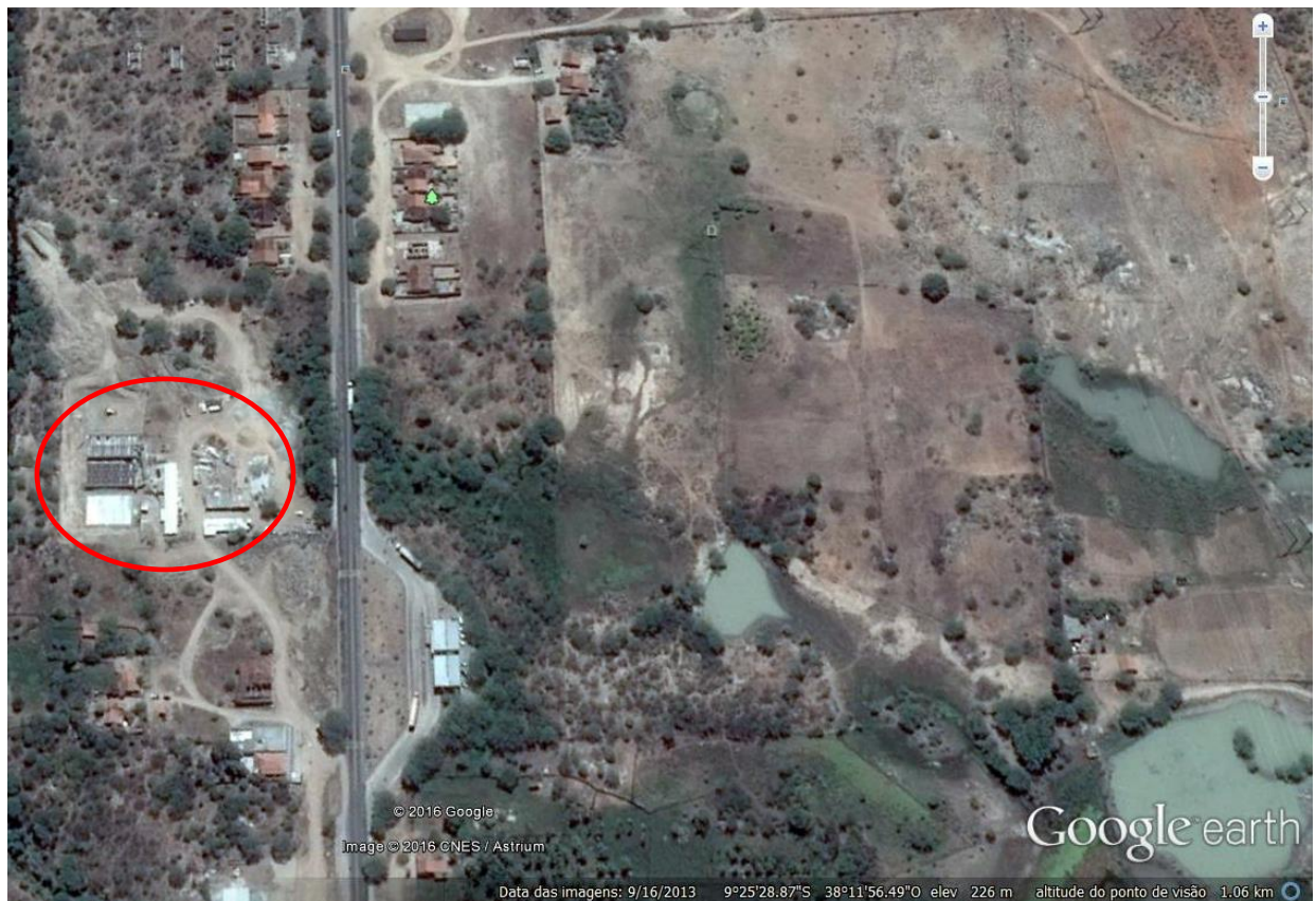
Figura 2 - Vista geral do posicionamento da ETE 02 - BTN
