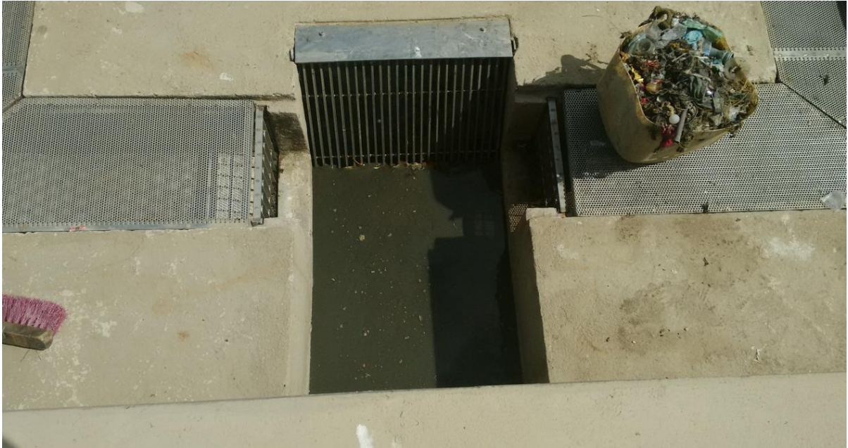
Figura 4 - Grades após realização da limpeza.
