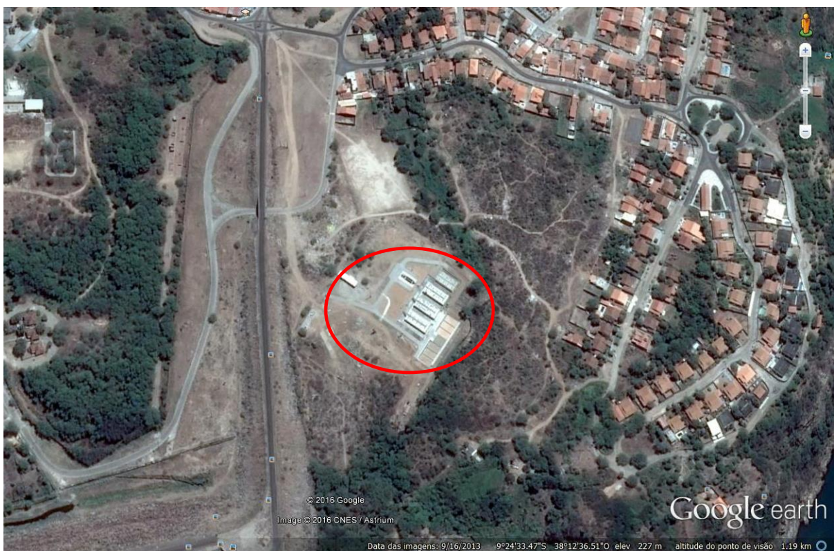
Figura 1 - Vista geral do posicionamento da ETE 01 - Centro
