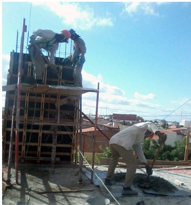
Figura 4.3 – Aplicação do concreto.
