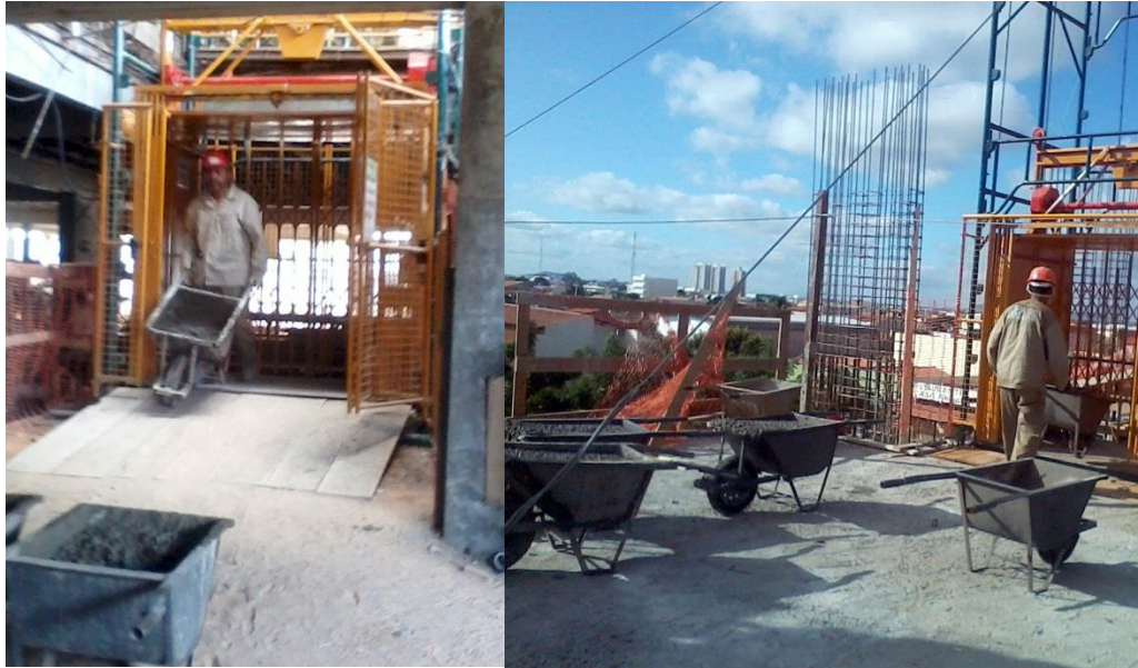
Figura 4.2 – Transporte do concreto.
