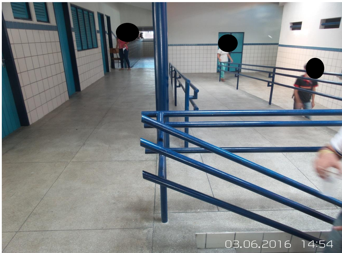
Figura 2 - Rampa de acessibilidade para alunos com deficiência ou mobilidade reduzida acesso: pátio, sala dos professores, cantina, auditório da escola, biblioteca.
