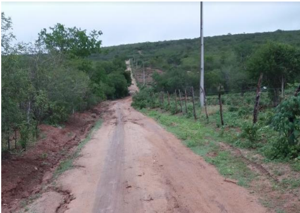
Figura 14: Acesso a agrovilas e aos lotes
