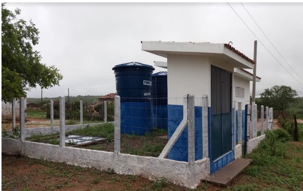
Figura 10: Projeto para decimização de água (ainda sem funcionamento)
