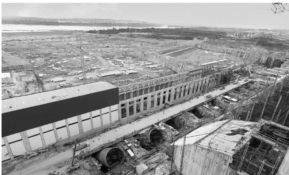
Figura 1 - Vista aérea da construção da usina hidrelétrica Belo Monte no Pará.
