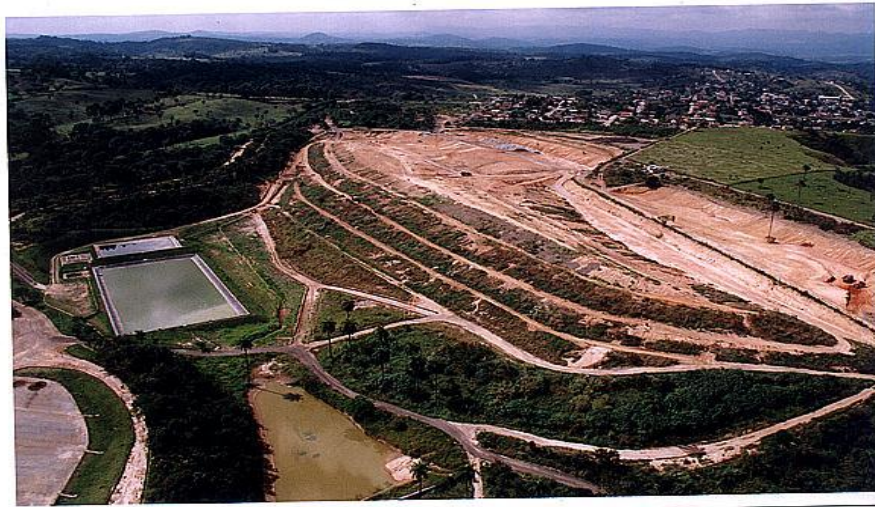
Figura 3: Aterro sanitário em Belo Horizonte.
