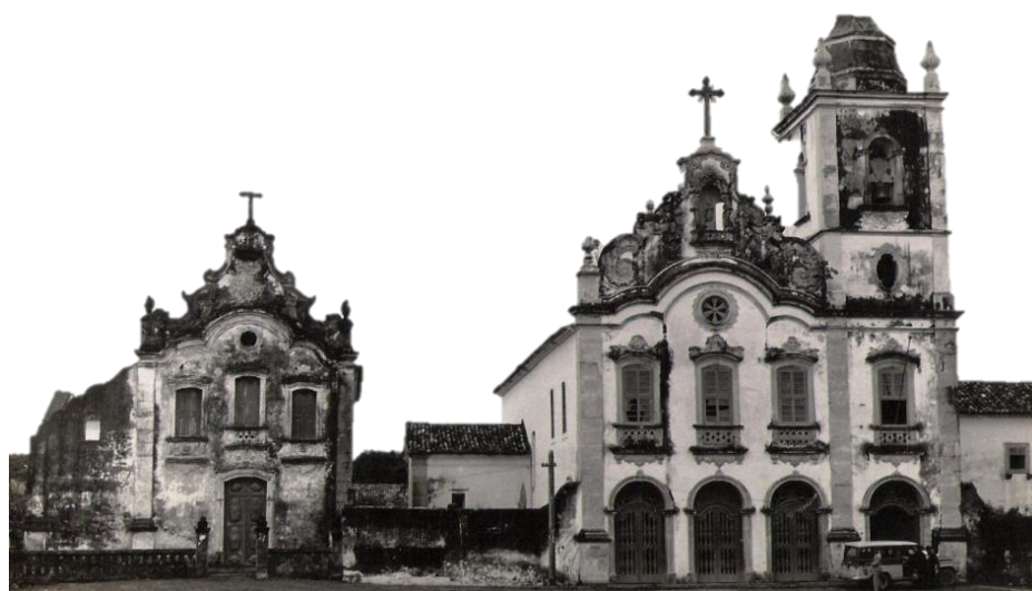
Figuras 61 e 62:– Muro do cemitério do Convento Franciscano Fachada do Convento com cemitério murado. Fonte: Arquivo da Secretaria de Estado da Cultura de Alagoas e Acervo Digital do Iphan.
