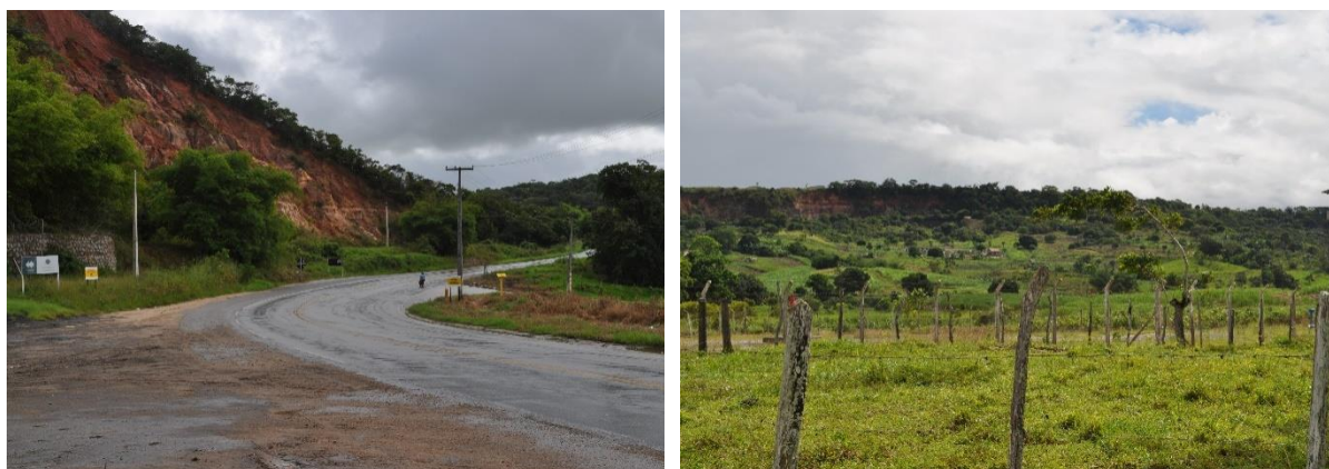
Figura 5 - Sinais de Movimento de massa em cortes de estradas na BR424 (Marechal Deodoro) e na estrada de acesso a cidade do Pilar.
