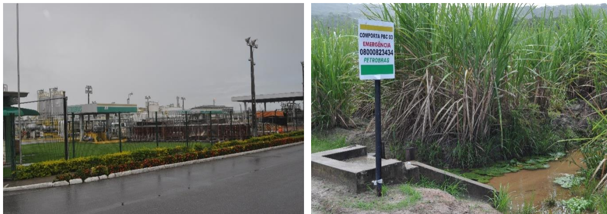
Figura 14 - Estação de Produção de Pilar (EPPIR) e Unidade de Processamento de Gás Natural de Alagoas (UPGN-AL), e detalhe de estruturas de emergência instaladas no cruzamento da estrada com a rede de drenagem, para contenção de vazamento de óleo.
