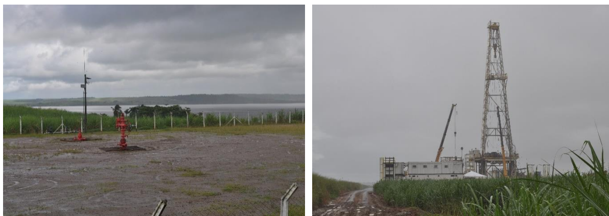
Figura 13 - Poço de produção de petróleo e equipamentos de perfuração de novo poço de produção no Campo de Pilar.
