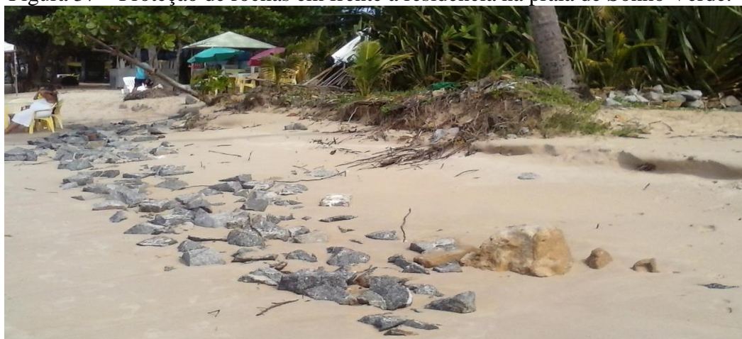
Figura 37 – Proteção de rochas em frente a residência na praia de Sonho Verde.
