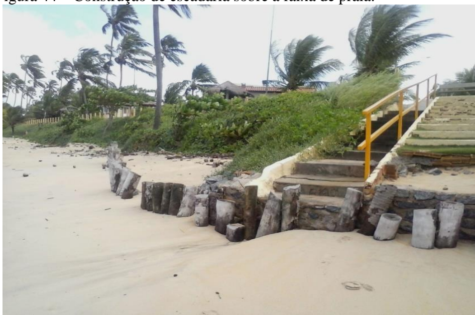
Figura 44 – Construção de escadaria sobre a faixa de praia.
