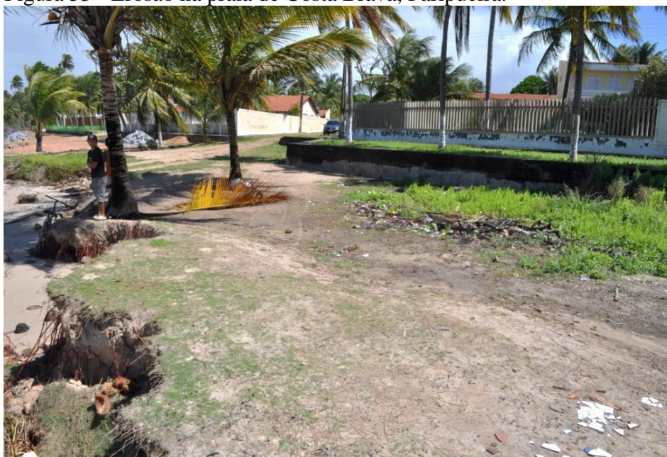
Figura 53 - Erosão na praia de Costa Brava, Paripueira.
