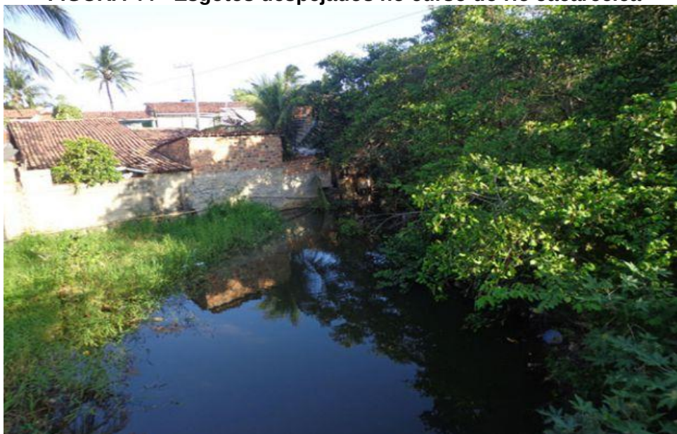
FIGURA 44 - Esgotos despejados no curso do rio Jacarecica
