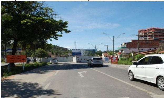
FIGURA 49 - Duplicação da AL 101 Norte, trecho do Bairro de Jacarecica (2016)
