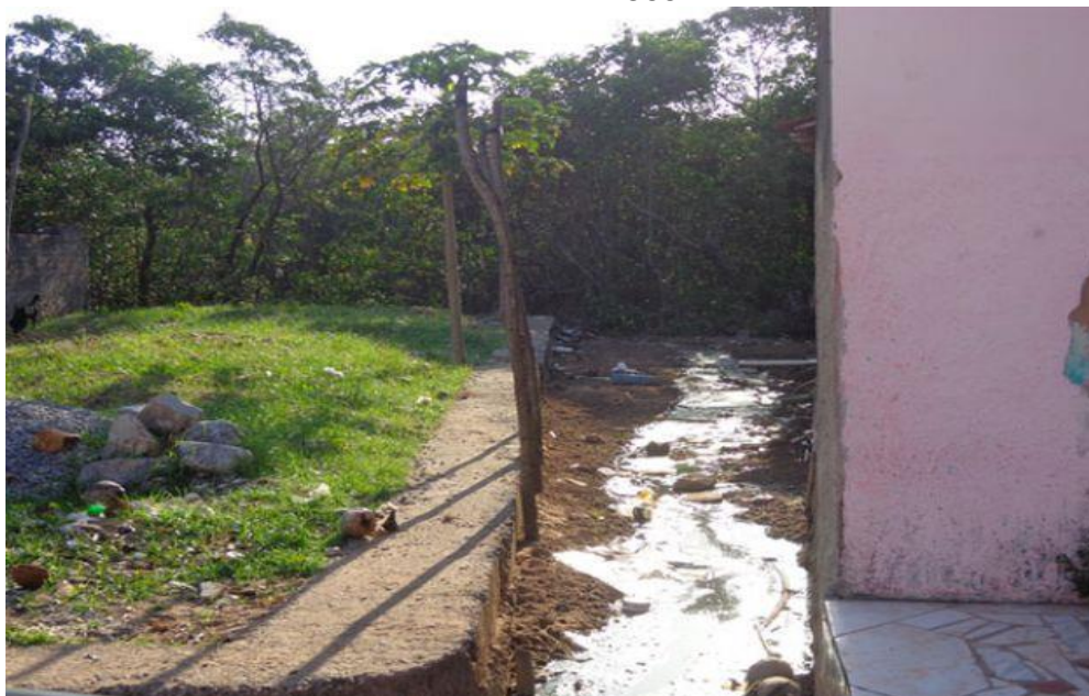
FIGURA 43 - Esgotos despejados no mangue próximo a praia da Sereia, no Riacho Doce
