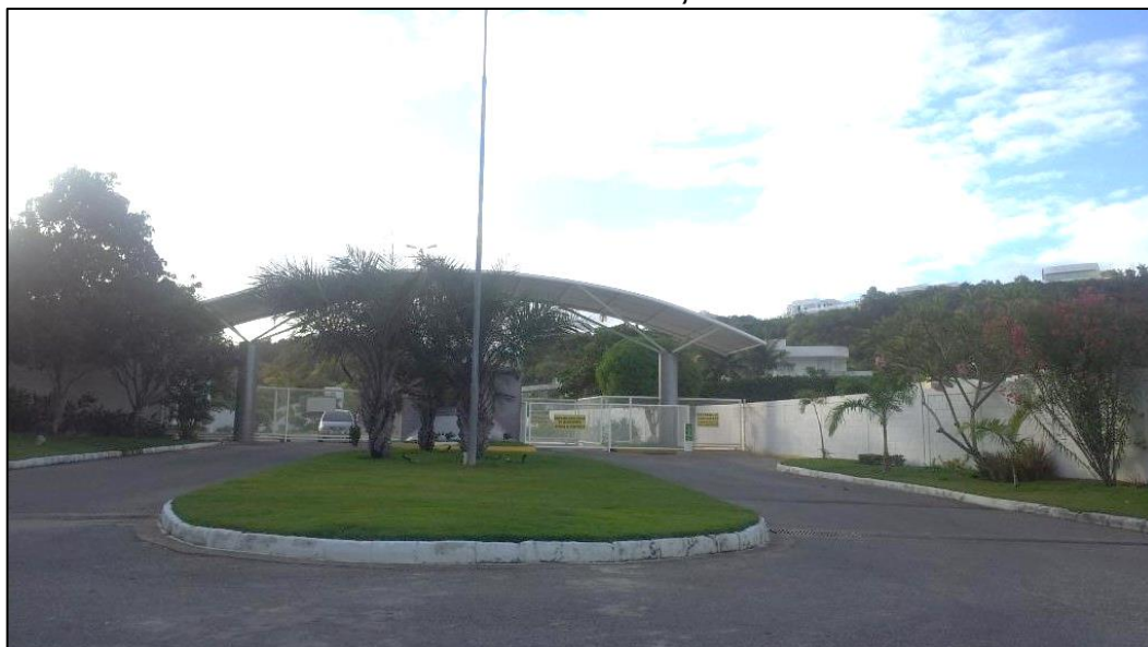
FIGURA 34 - Condomínio Ocean View, no bairro de Jacarecica
