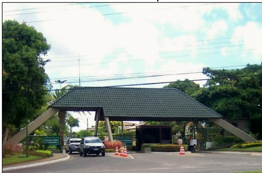
FIGURA 33 - “Condomínio” Aldebaran, localizado na porção oeste, no bairro Jardim Petrópolis
