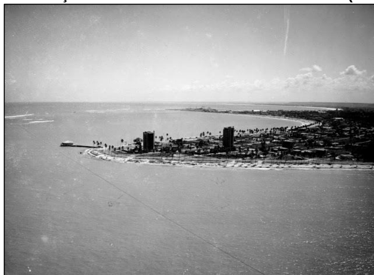
FIGURA 20 - Construção de edifícios no bairro da Ponta Verde (década de 1970)
