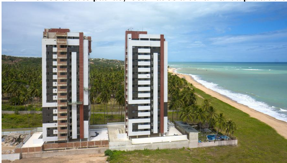
FIGURA 48 - Prédios de alto padrão, localizados à beira mar da praia de Guaxuma
