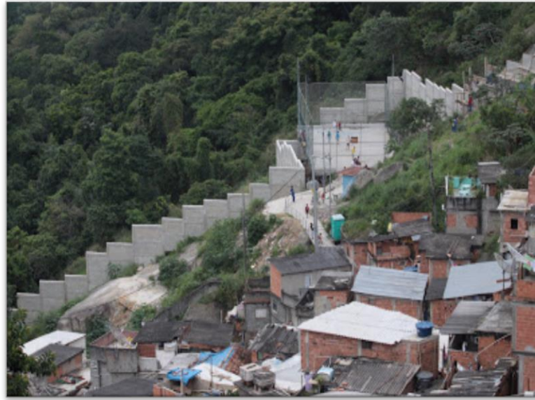
FIGURA 9 - Muro “Ecolimite” na favela Santa Marta, no Rio de Janeiro
