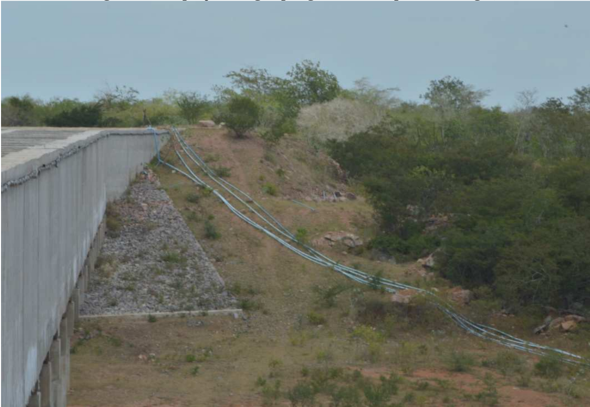
Figura 20 - Captação de água por gravidade no povoado Tinguí, AL
