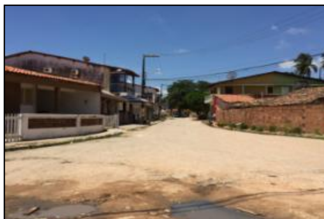
Figura 30: São Bento - água servida correndo a céu aberto na Avenida beira-mar
