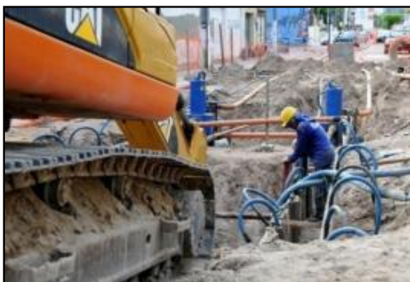
Figura 61: Obras de saneamento em área urbana
