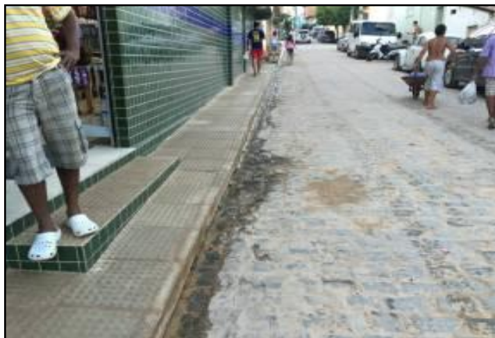
Figura 48: Lançamento de águas servidas das residências localizadas na área central de Maragogi, mesmo após urbanização e implantação de rede de esgoto - via pública no centro
