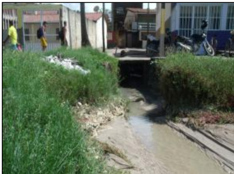
Figura 51: Galeria de águas pluviais transformada pelos moradores do Adélia Lira em esgoto - dejetos deságuam no trecho final da orla de Maragogi
