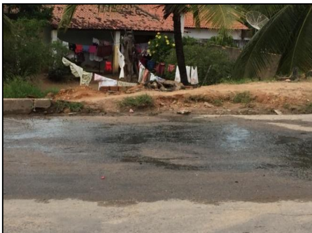
Figura 34: Esgoto correndo a céu aberto pela AL-101-Norte - Barra Grande
