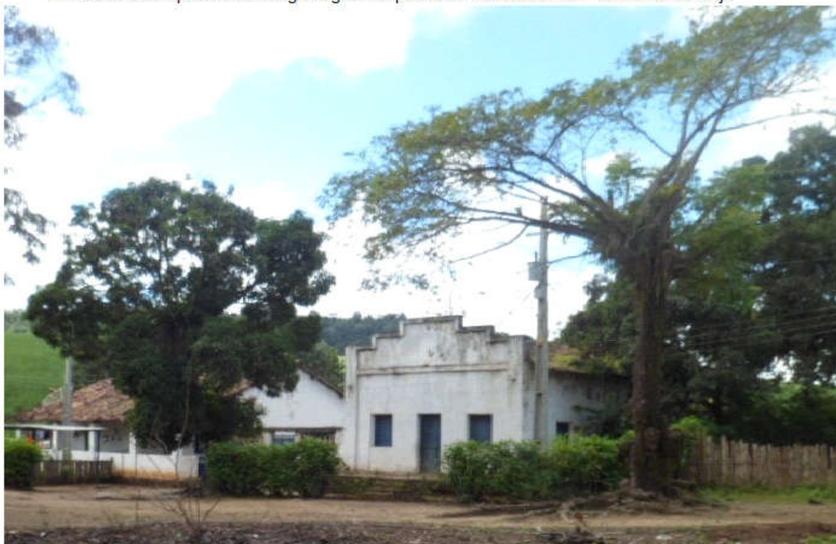
Escola da Vila Operária do antigo engenho Apolinário - Serra Grande - São José da Laje
