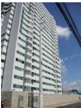
Figura 49 - Fachada do Edif. Terrazzos
