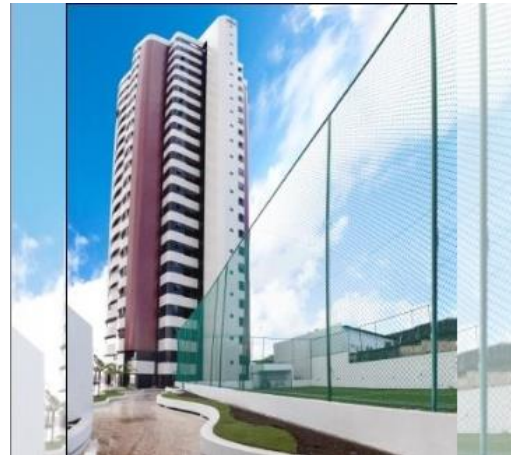
Figura 57 – Área de lazer Edif. Giardino di Mare
