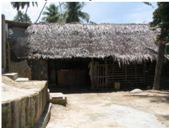
Figura 63- A casa do forno ainda com o telhado em palha de coqueiro.
