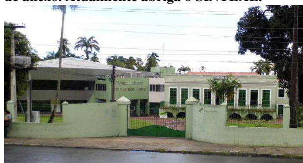
Figura 48- Edificação após reforma e construção de anexo. Atualmente abriga o SINTEAL.
