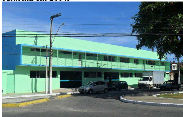
Figura 16- Centro de Saúde da Maravilha após reforma em 2014.
