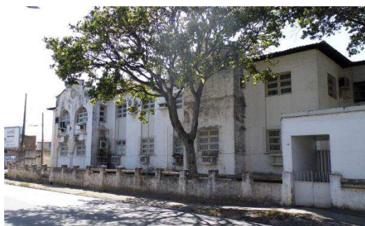
Figura 14- Fachada principal da antiga LBA.
