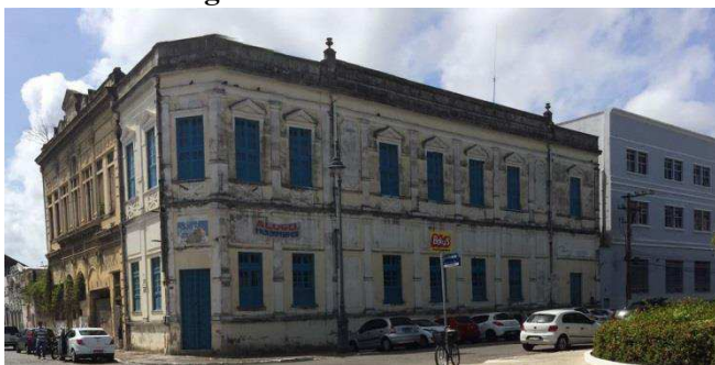
Figura 2 - Edificação onde funcionou a UEM no bairro de Jaraguá.
