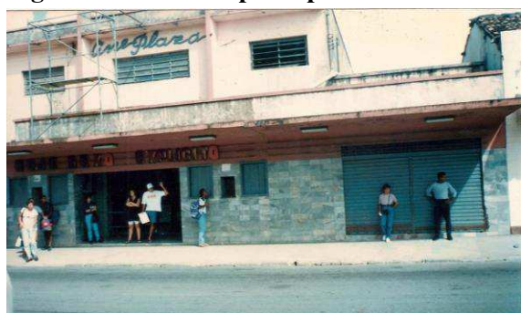
Figura 61- Fachada principal do Cine Plaza.
