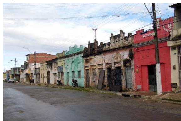
Figura 28: Casario do Canal da Levada.
