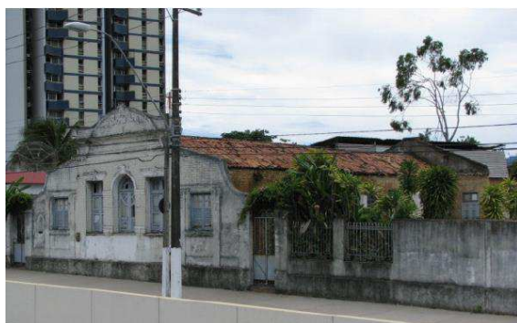
Figura 93- Edificação antes da reforma.
