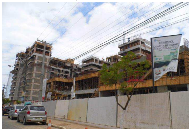
Figura 20- Construção dos edifícios.
