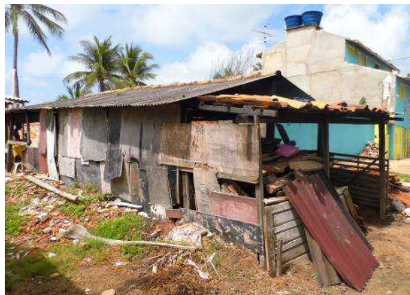
Figura 64- A casa do forno com o telhado em telha de fibrocimento.
