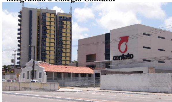
Figura 94- Edificação após reforma integrando o Colégio Contato.
