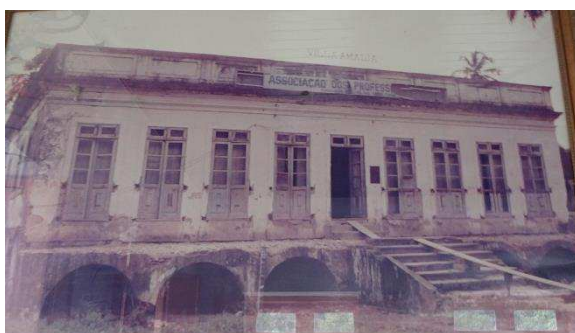
Figura 47- Vila Amália antes da reforma.
