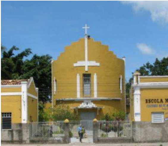
Figura 16- Fachada da igreja da Casa dos Pobres.
