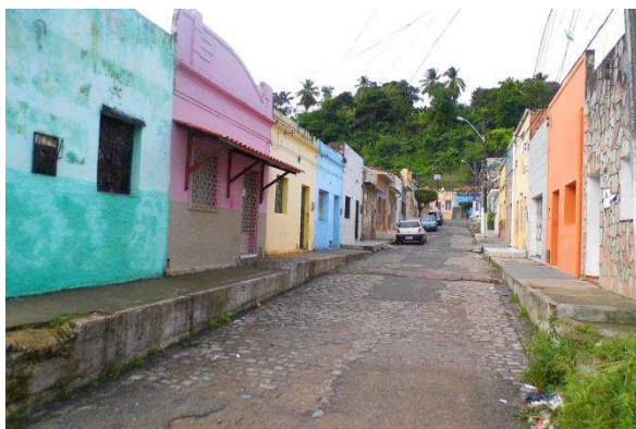
Figura 75- Casario da Vila Operária da Fábrica Alexandria.
