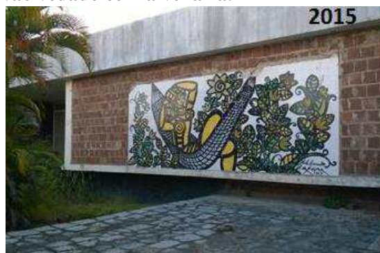
Figura 25- Residência Afonso Lucena com vão vedado com alvenaria.
