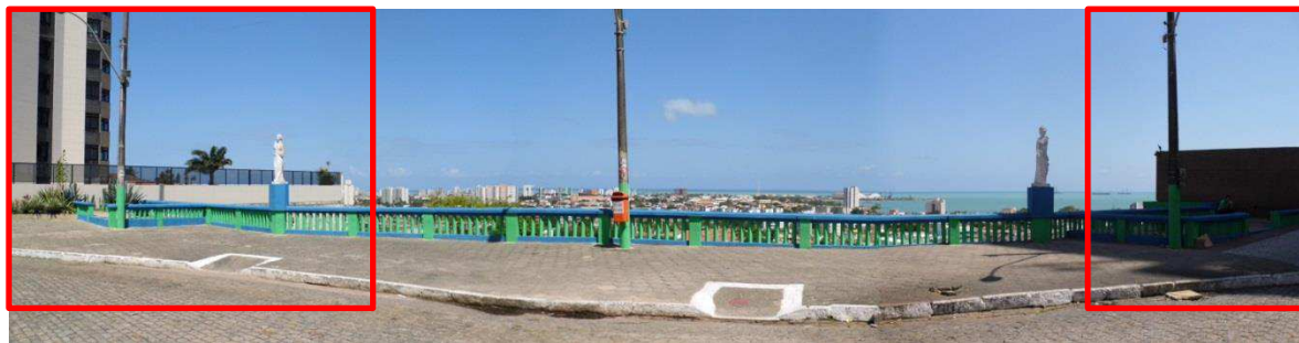
Figura 86- Mirante São Gonçalo. Em destaque edificações que diminuem o ângulo de visão.
