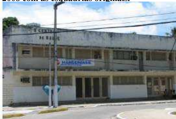
Figura 15-Centro de Saúde da Maravilha em 2008 com as esquadrias originais.
