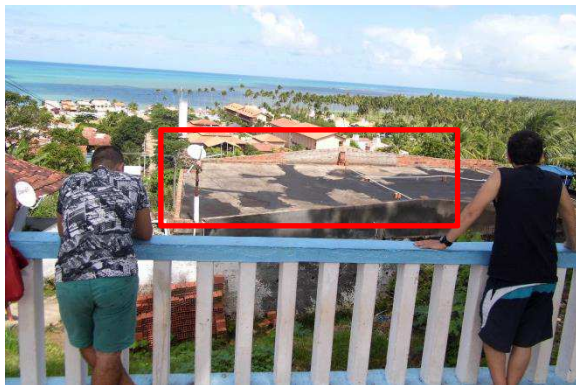
Figura 89- Edificação embargada pela prefeitura.
