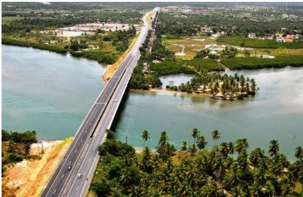
Figura 06 - Ponte Engenheiro Celso Araújo
