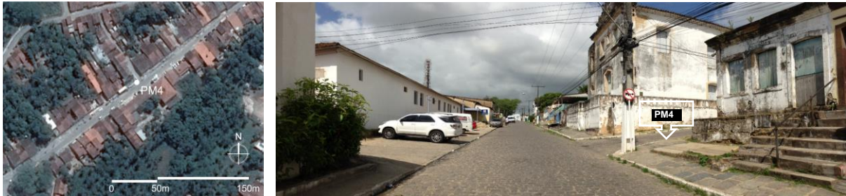
Figura 20 - PM4 - Rua Ladislau Neto.
