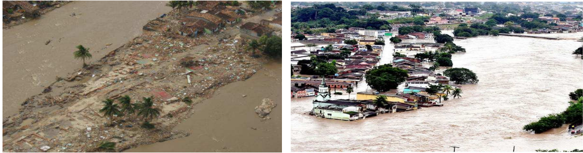
Figura 1 – Destruição das cidades de Murici (esquerda) e Branquinha (direita) provocada pela cheia de 2010 na Bacia do Rio Mundaú
