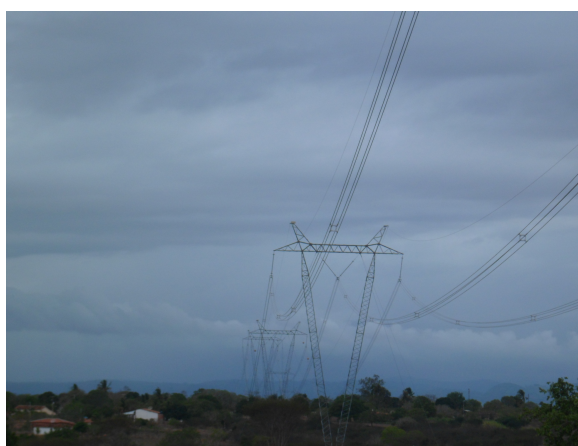
Figura 7 – Rede de transmissão em 500 kV, de Xingó para Messias.
