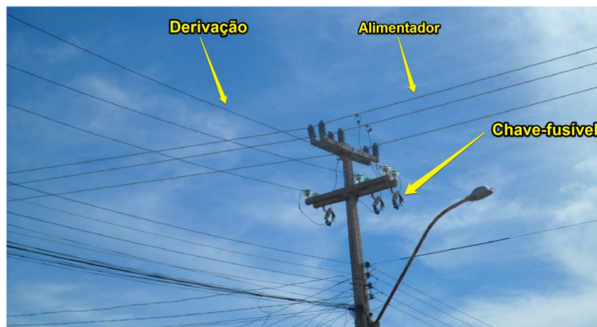
Figura 21 – Imagem de um nó de passagem em uma rede de distribuição.
