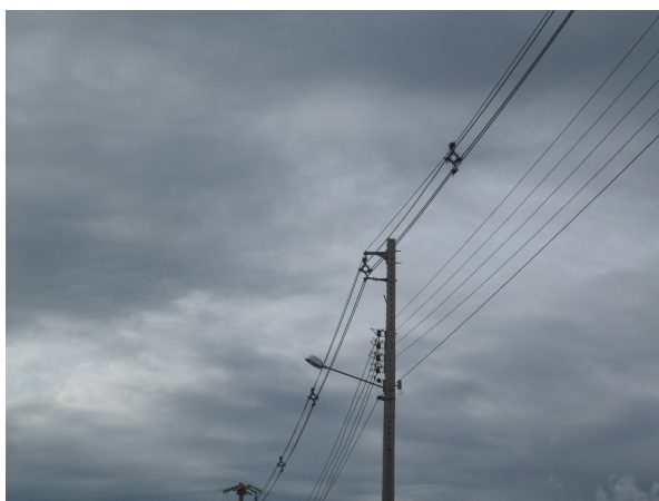
Figura 8 – Rede aérea compacta.
