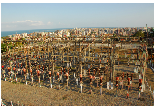
(a) Subestação real
