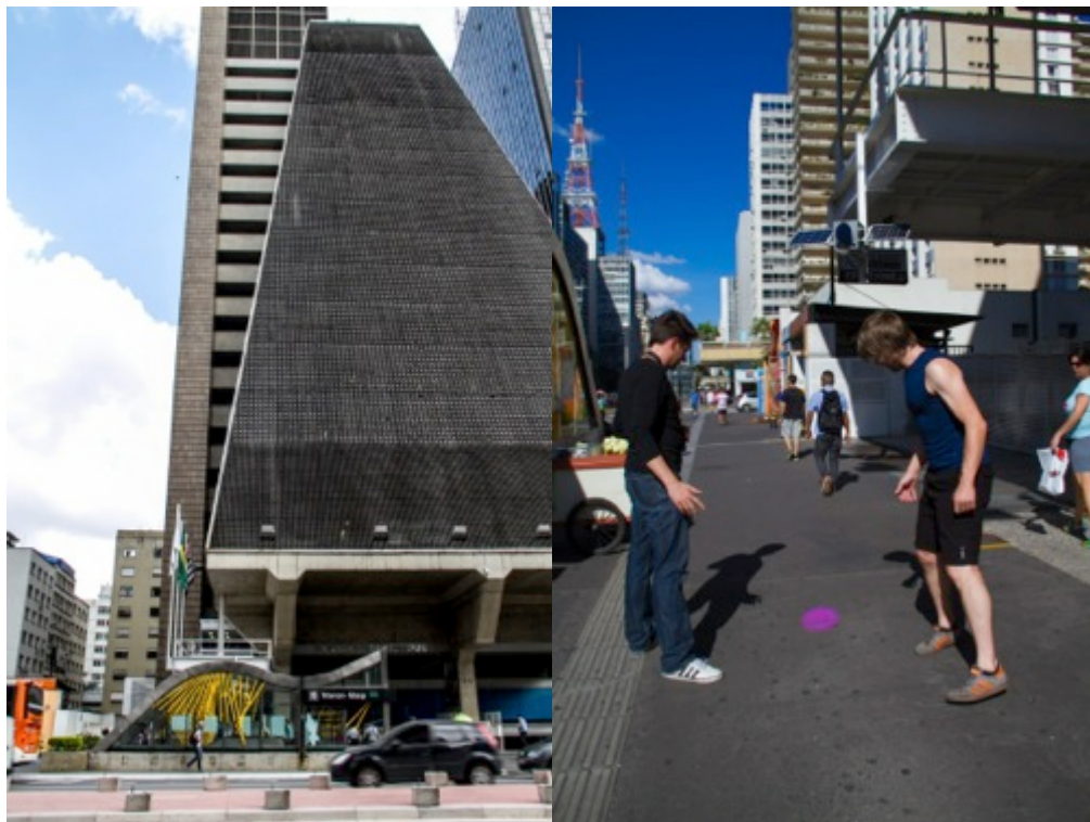
Figura 26: Edifício da Fiesp que abriga o FILE e exemplo de instalações que acontecem fora do edifício.
