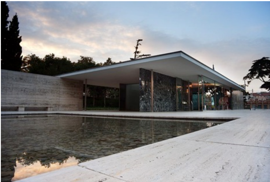
Figura 5: Pavilhão Barcelona - Mies van der Rohe Fonte: http://www.infopedia.pt/ e https://meiaum.files.wordpress.com
