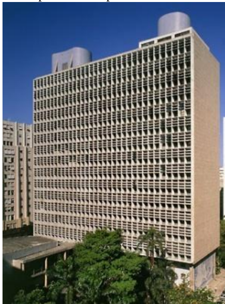
Figura 1- Ministério da Educação e Saúde (atual Palácio Gustavo Capanema), primeira grande edificação que fez uso por completo dos dispositivos de sombreamento.
