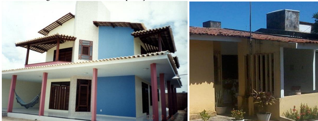
Figura 2.2 – Elementos de proteção solar e ontra a chuva. Varandas e brises.
