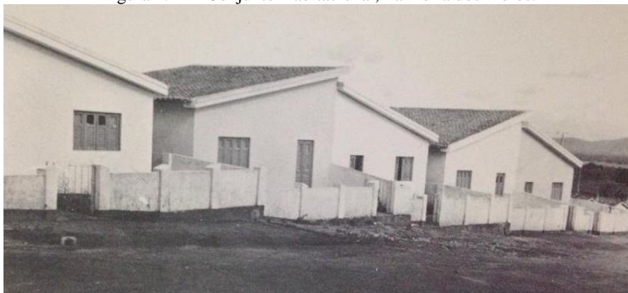
Figura 2.11 – Conjunto Habitacional, Palmeira dos Índios.
