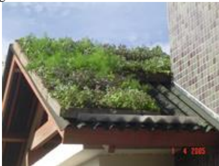
Figura 3.18 - Sistema alveolar de telhado verde
