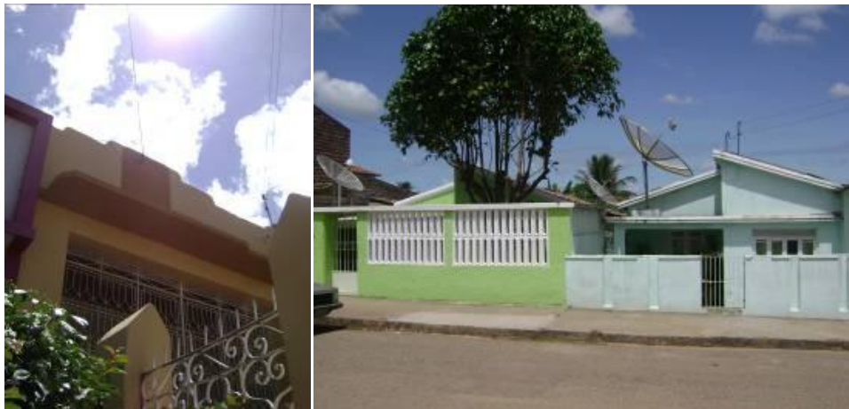
Figura 2.10 - Elementos de proteção solar e permeabilidade aos ventos em habitações na cidade de Palmeira dos Índios-AL.
