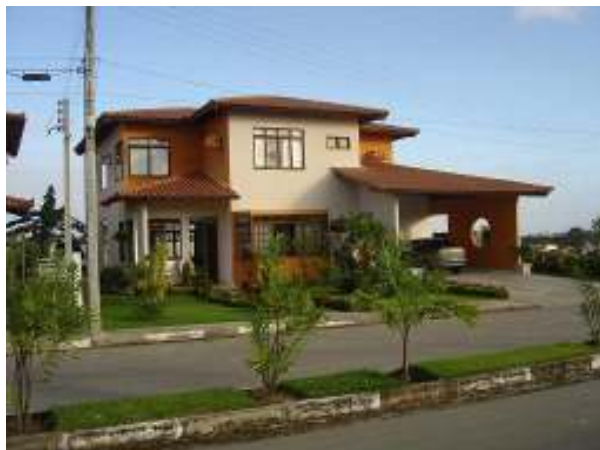
Ilustração 17 - Exemplo de residência no Condomínio San Nicolas, Maceió. Imóveis ainda constam como terrenos nos registros da Prefeitura.
