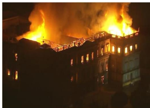
Figura 2 - Incêndio no MN em 2018.
