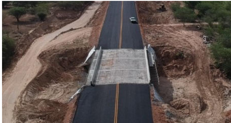
Figura 31 – Execução de ponte sobre o rio Croatá.
