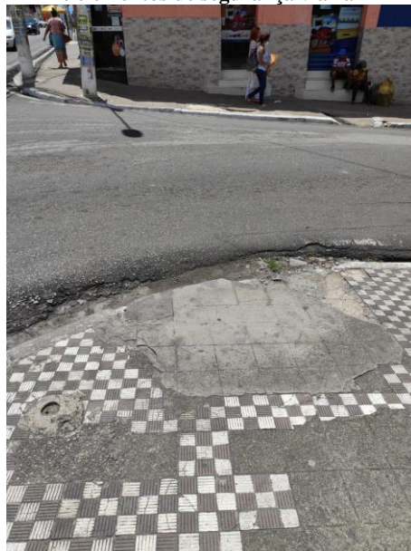
Figura 14 - Travessia sem acessibilidade e elementos de segurança viária
