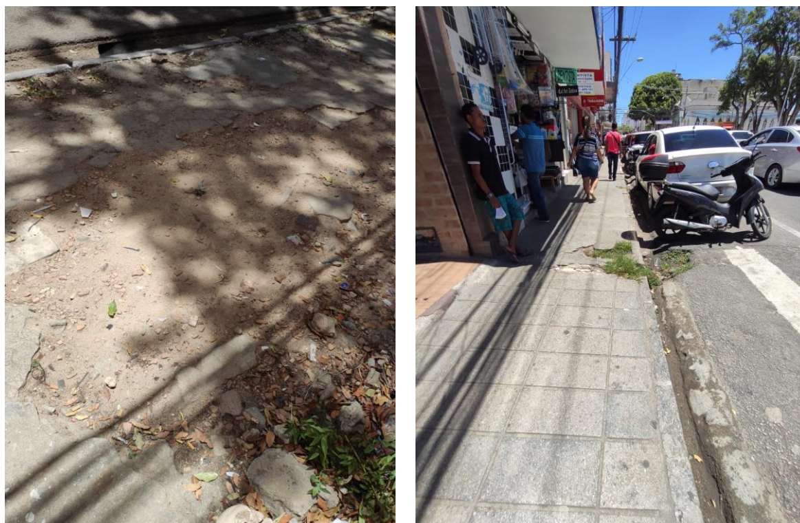
Figura 10 - Calçadas com buracos e sem pavimento na área em estudo
