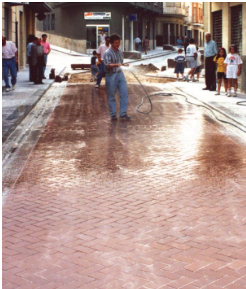
Figura 10 – Ilustração da finalização do assentamento de pavimentação cerâmica
