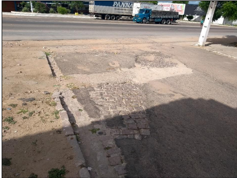
Figura 43: Rua Frei Damião, Av. Caxangá ao fundo
