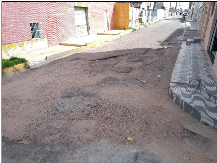
Figura 40: Rua Maurício de Nassau, próxima a ligação com a Av. Caxangá
