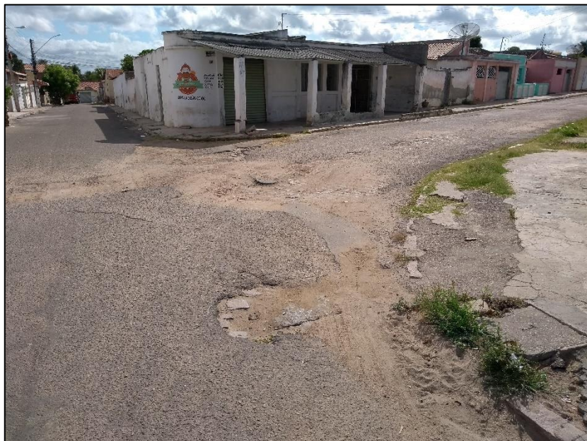
Figura 42: Cruzamento das ruas Frei Damião e Nossa Senhora do Rosário
