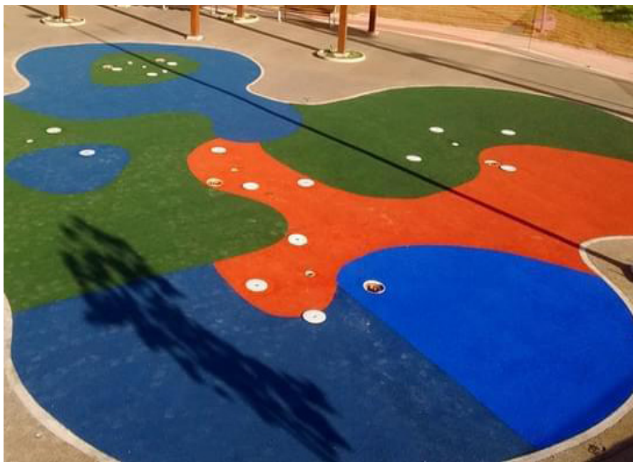
Figura 100. Piso de borracha drenante para playground.
