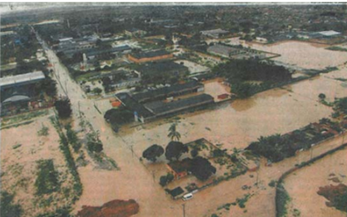
Figura 34. Distrito Industrial (atual Polo Multissetorial) alagado pelas chuvas que levaram a prefeitura a decretar estado calamidade pública.
