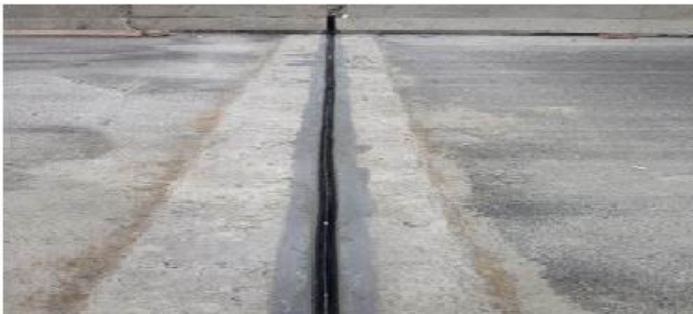
Figura 6: Junta de dilatação entre as placas de uma ponte.
