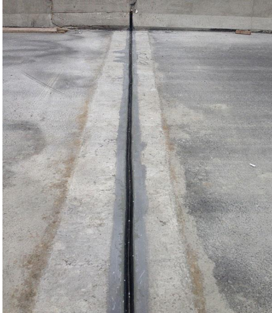
Figura 2: Junta de dilatação entre as placas de uma ponte.
