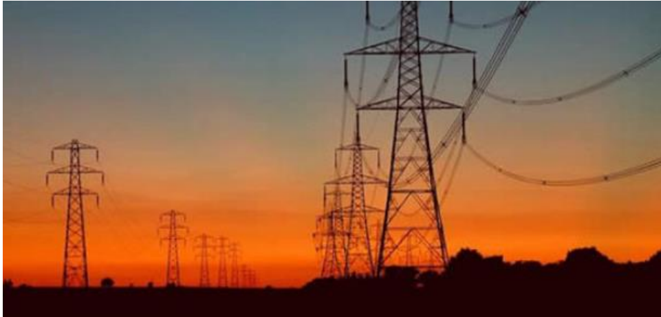
Figura 1: Fios da rede elétrica com folga devido aos efeitos da dilatação.
