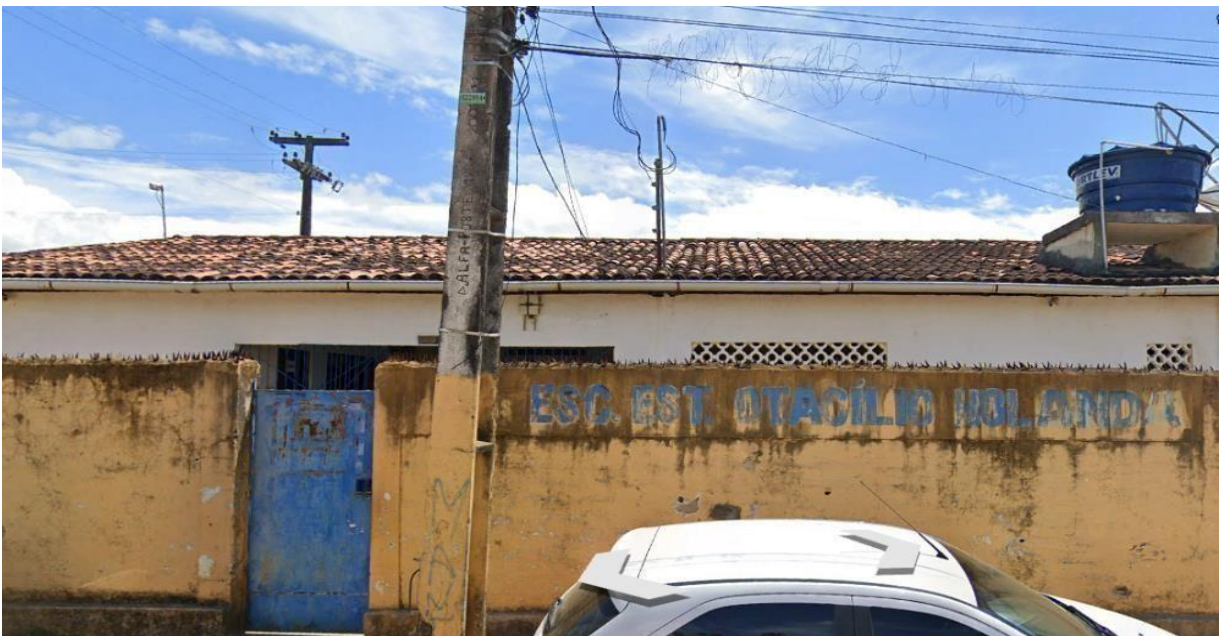
Imagem 11: Faixada da Escola Estadual Otacílio Holanda de Andrade.
