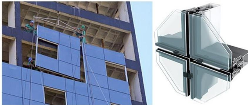
Figura 32 - Instalação do Sistema Unitizado e detalhe do encaixe no perfil. Fonte: Metalica.com.br., 2019.
