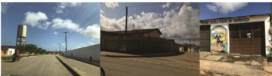
Figura 26: Presença de muros nos lotes do conjunto
