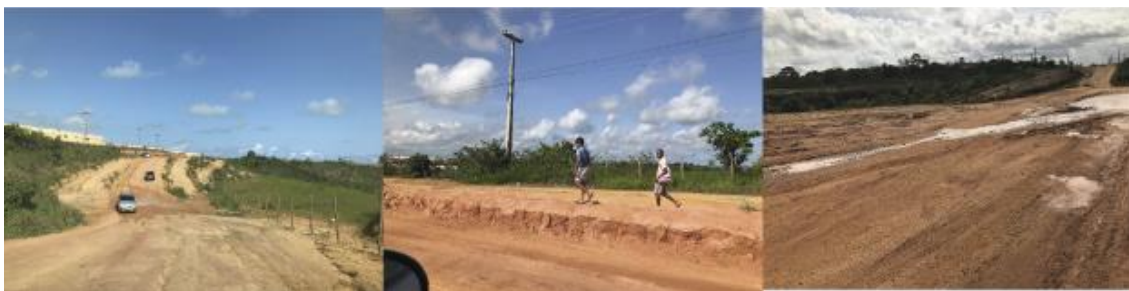
Figura 27: Condições de acesso ao conjunto José Aprígio Vilela
