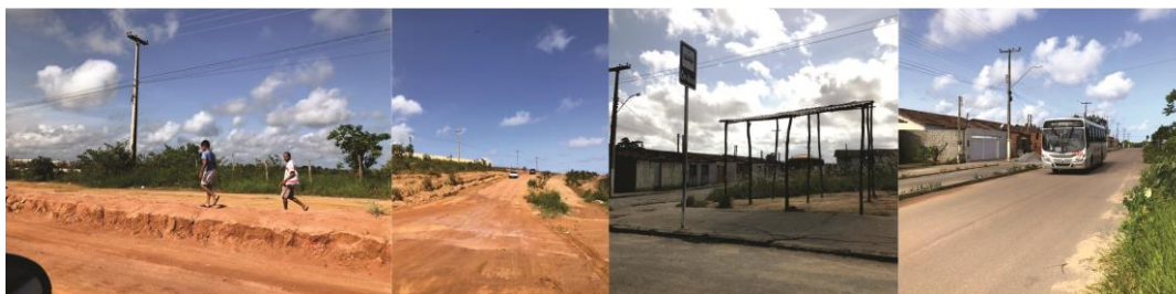
Figura 29: Condições das vias e abrigo de ônibus improvisado.
