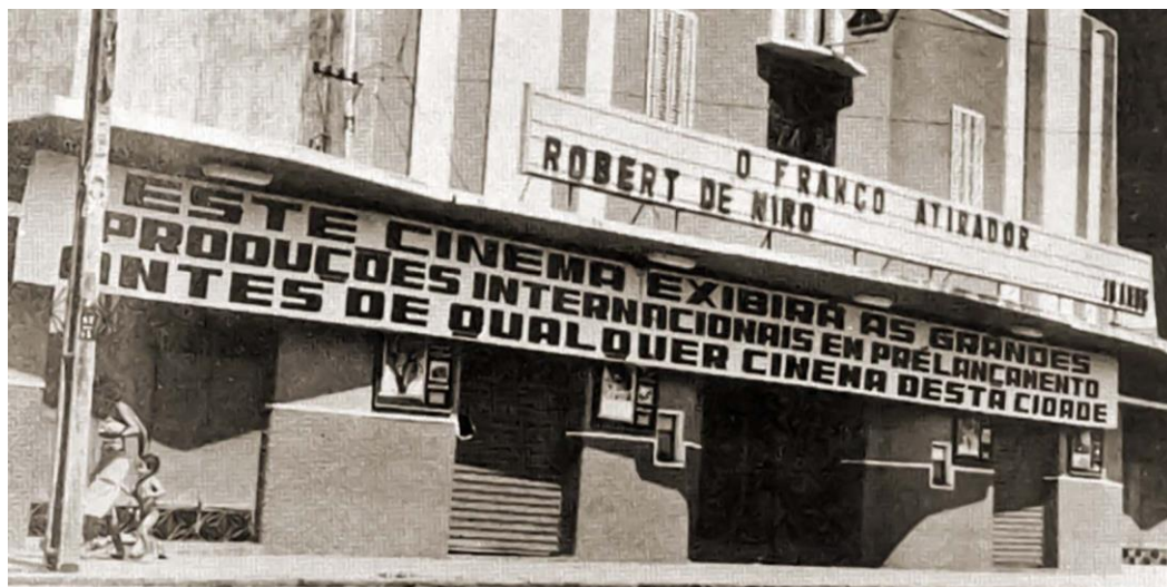
Figura 68: Cinema Lux, prédio com fachada protomoderna.
