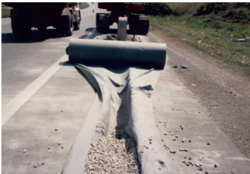
Figura 3: Aplicação de manta de GTN.
