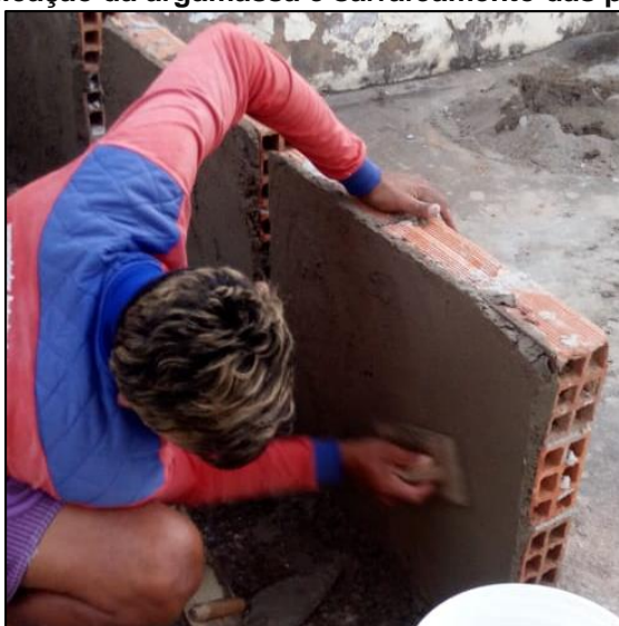
Figura 16 - Aplicação da argamassa e sarrafeamento das paredes..
