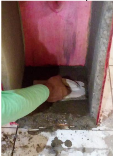
Figura 20 - Sarrafeamento e finalização das caixas.
