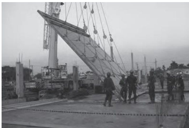
Figura 2.2 - Processo construtivo Tilt-up
