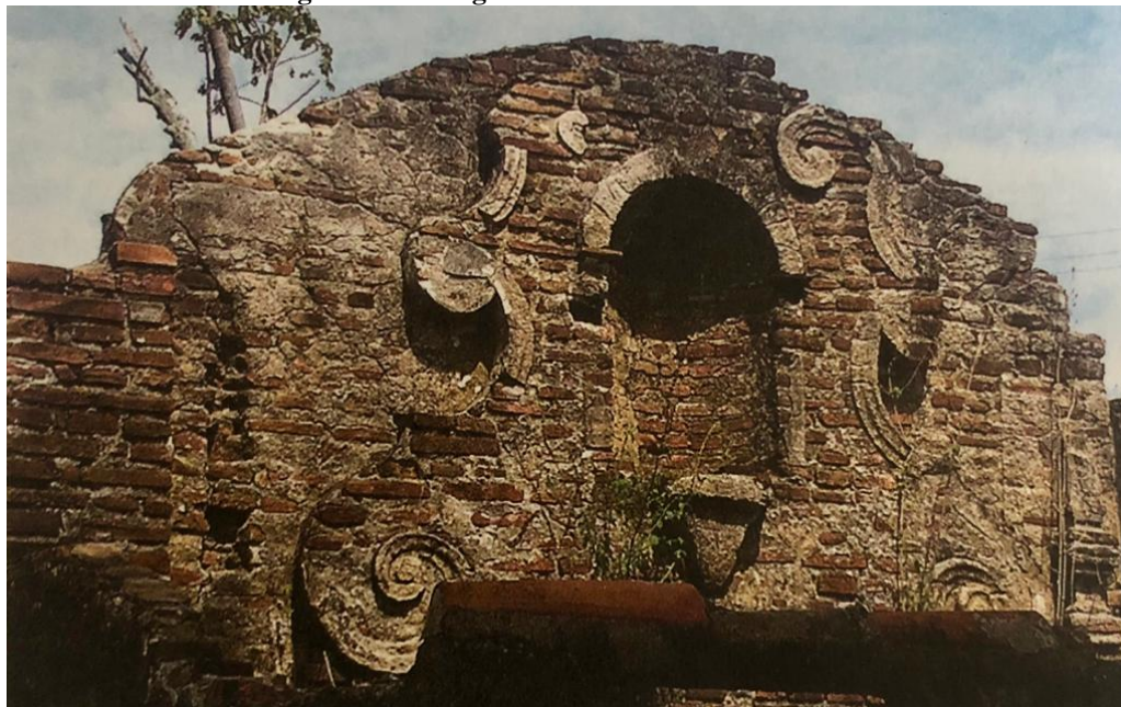
Imagem 17 – Fotografia da face sul da bica de São Francisco
