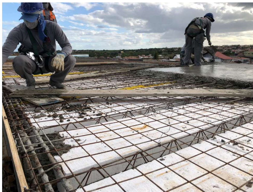
Figura 5 - Representação real da execução de laje treliçada
