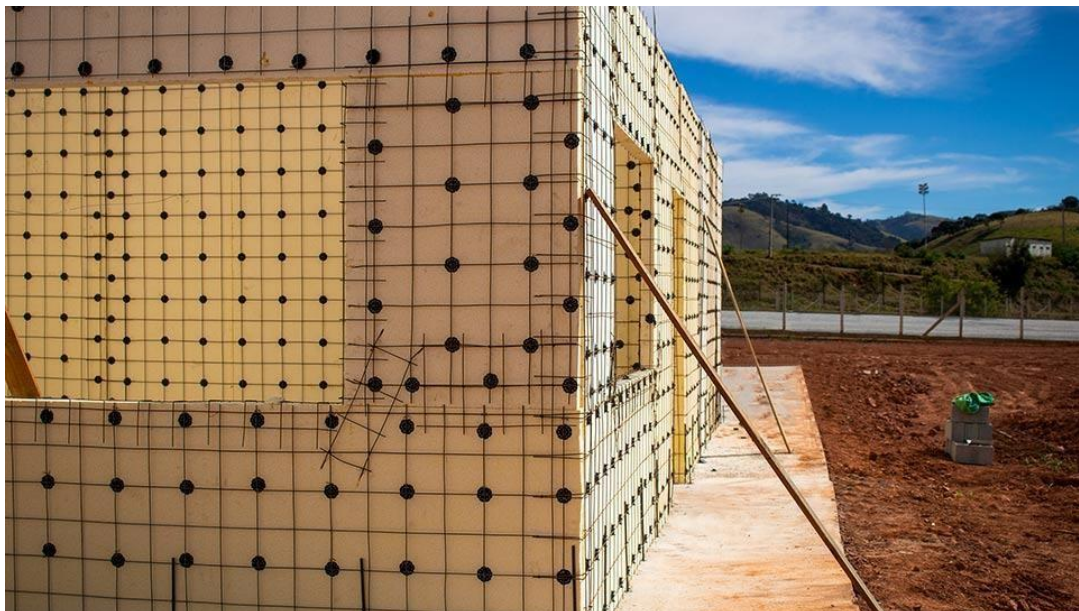
Figura 4 Paredes de EPS em processo de montagem.
