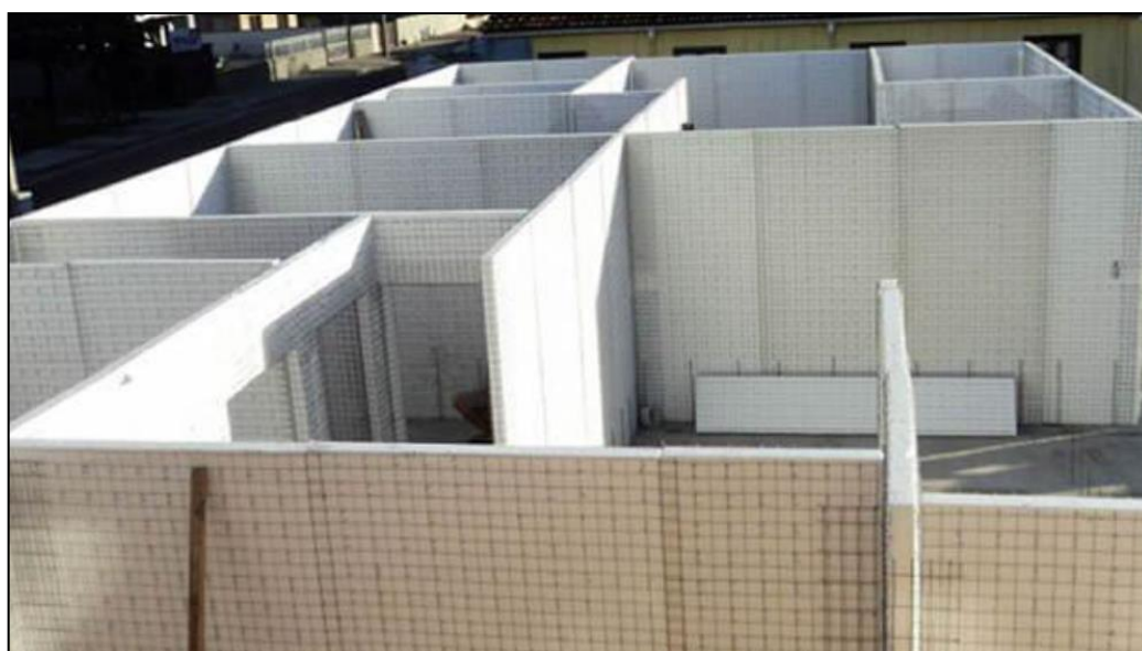
Figura 7 Construção com painéis sanduiche.
