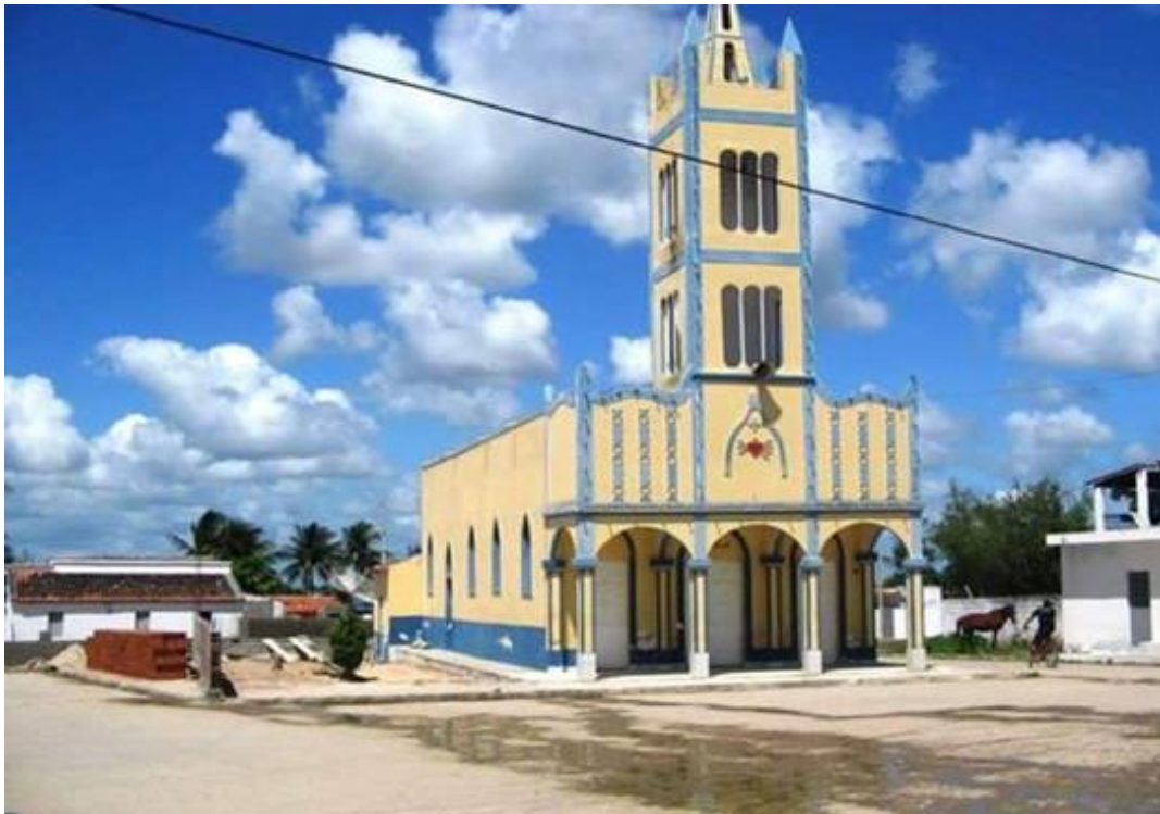
Foto 9: terceira reforma da capela
