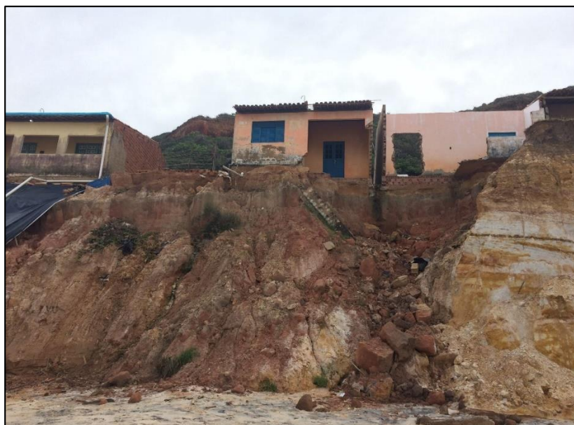
Figura 7: Efeitos da erosão marinha em residências construídas em área de risco em Lagoa Azeda
