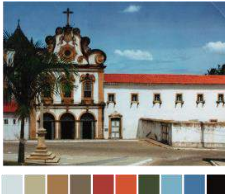
Figura 21 – Fachada do conjunto franciscano: igreja, convento e capela da Ordem Terceira
