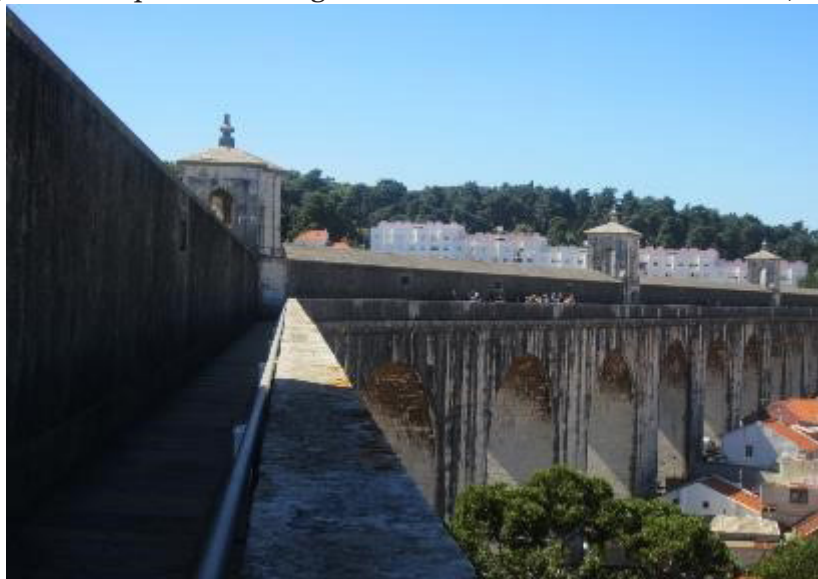
Figura 1 – Aqueduto das Águas Livres sobre o vale de Alcântara, 2015.
