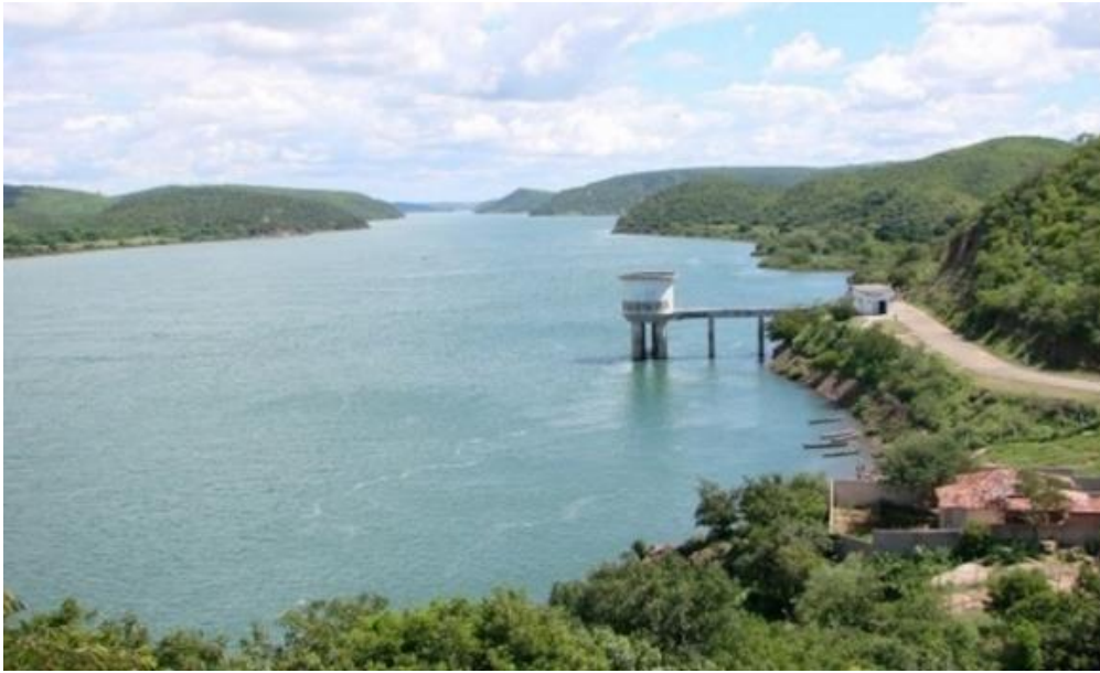
Figura 3.8 – Captação de água em Pão de Açúcar - Alagoas
