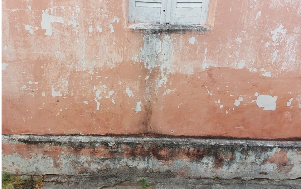
Figura 4.13 - Residência construída a mais de 38 anos
