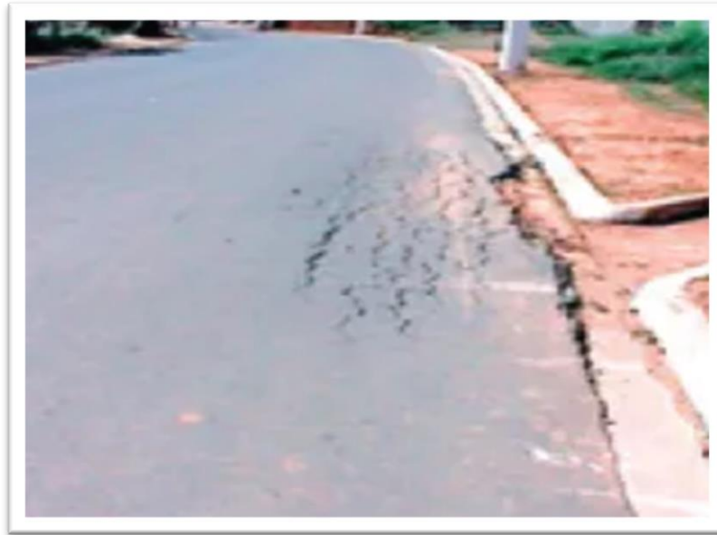
Figura 6 - Afundamento plástico
