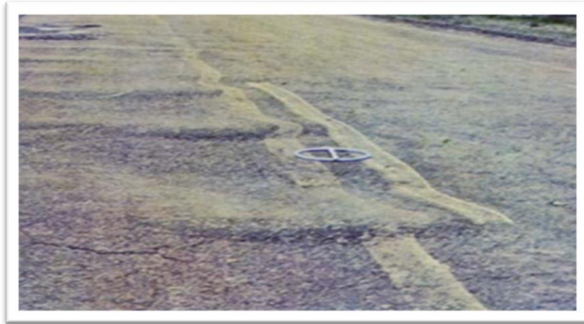
Figura 7- Ondulações ou Corrugações
